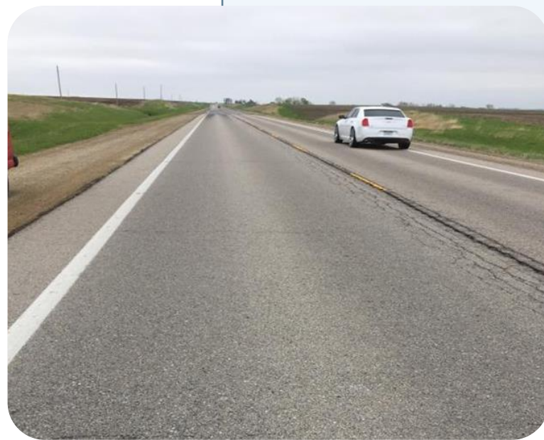
Spray Paver – 0.34 gal/yd 2
