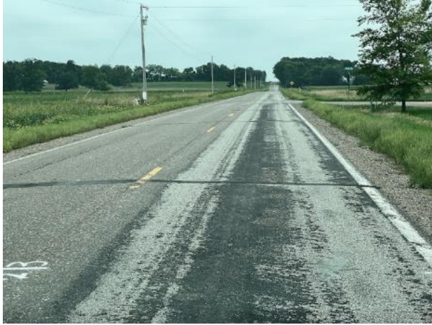
(a) Single chip seal CSAH-8
