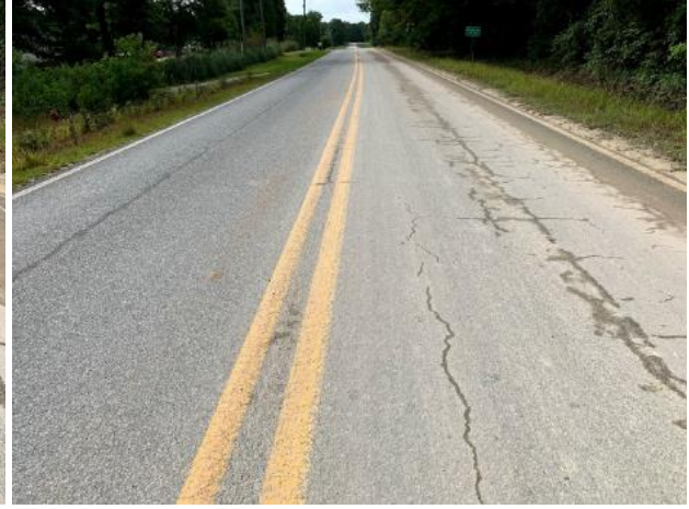
(d) Crack sealing + chip seal
