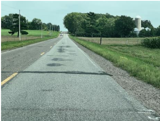
(e) Triple chip seal CSAH-8
