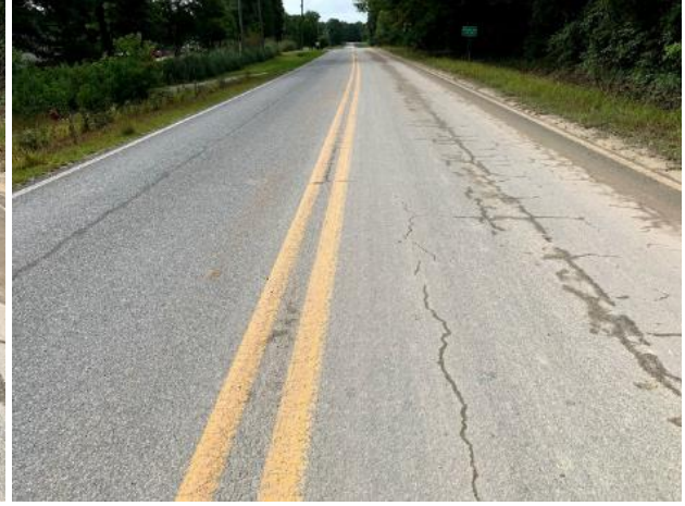
(d) Crack sealing + chip seal
