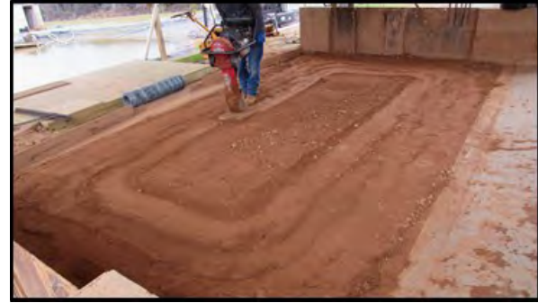
(d) jumping jack compaction plate
