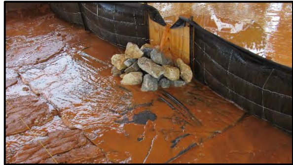
(d) geotextile flow dispersion
