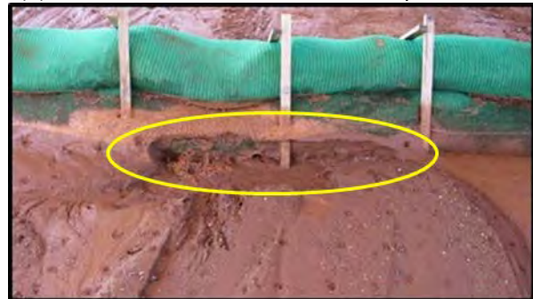
(d) undermining – pyramid installation
