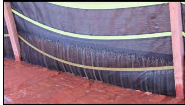
(d) SRSF effluent discharge
