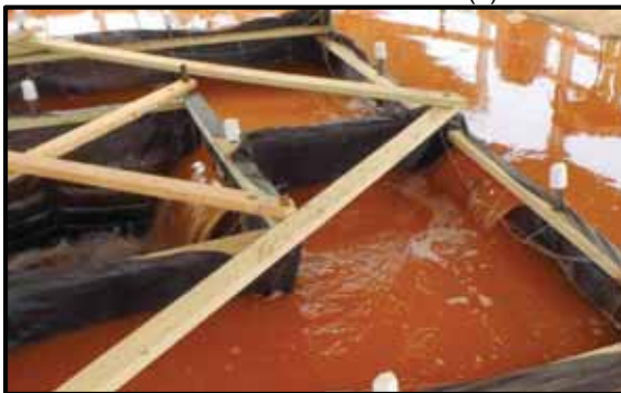
(d) weirs under full impoundment
