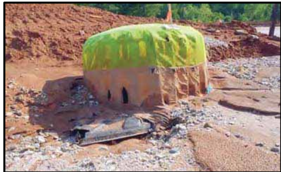
(d) manufactured device dislodgement
