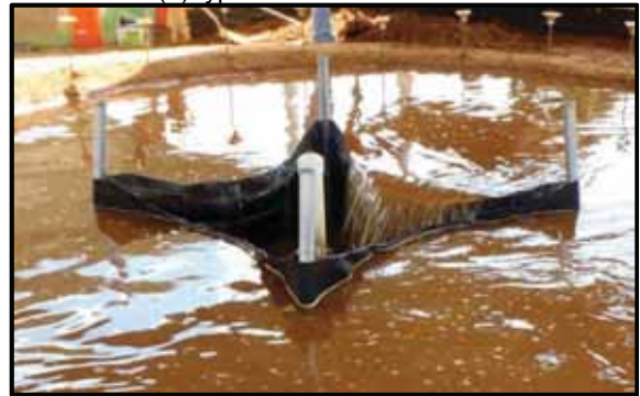
(d) fence post installation
