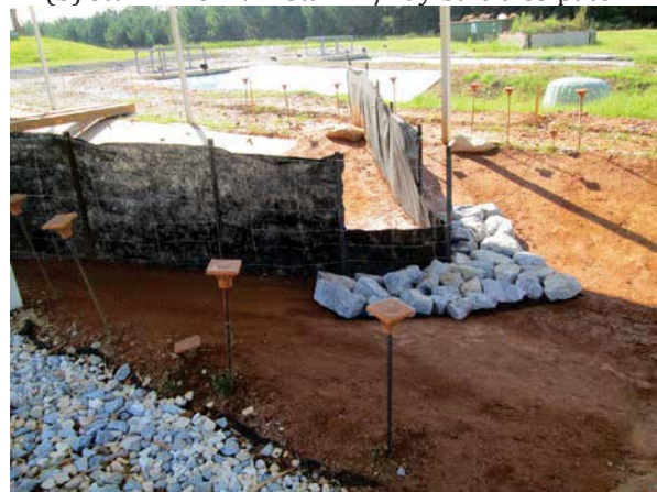
(d) TDOT enhanced install. w/rip rap dissipater
