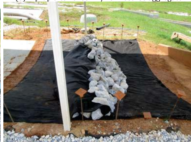
(d) 8 oz. FF choker secured w/riprap
