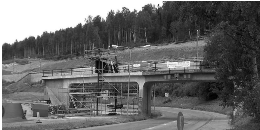
Figure 2.17 Örnköldsvik Bridge (Bergström, Täljsten, and Carolin 2009)
