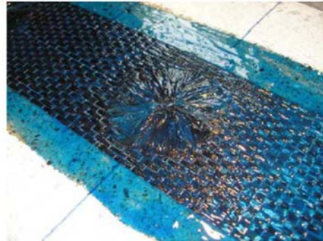
(d) Saturated FRP anchor and FRP sheet
